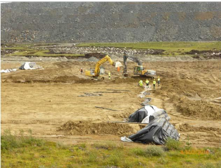
Kuva 12. Mattorullien varastointia valmistajan ohjeiden mukaisesti. Kuva: Hannu Heikkilä.
