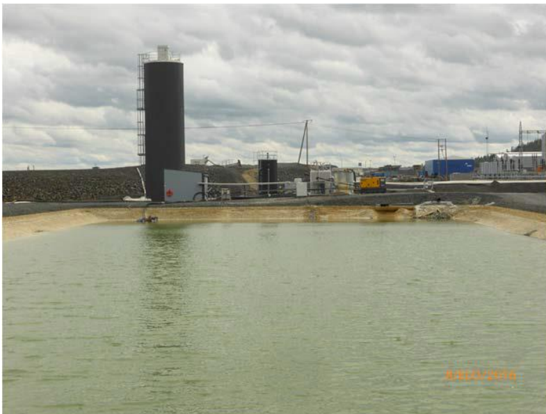
Kuva 14. Altaan pintaa laskettu ennen putkitöitä. Kuva Hannu Heikkilä.
