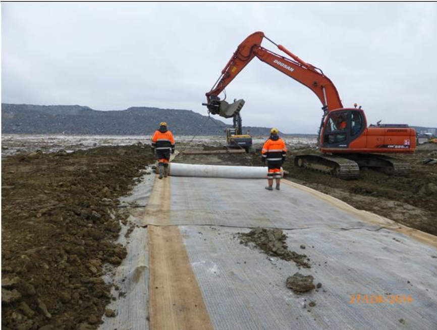
Kuva 13. Maton asennusta asennusalustan päälle. Levityskone liikkuu asennusalustan sivulla. Kuva: Hannu Heikkilä.
