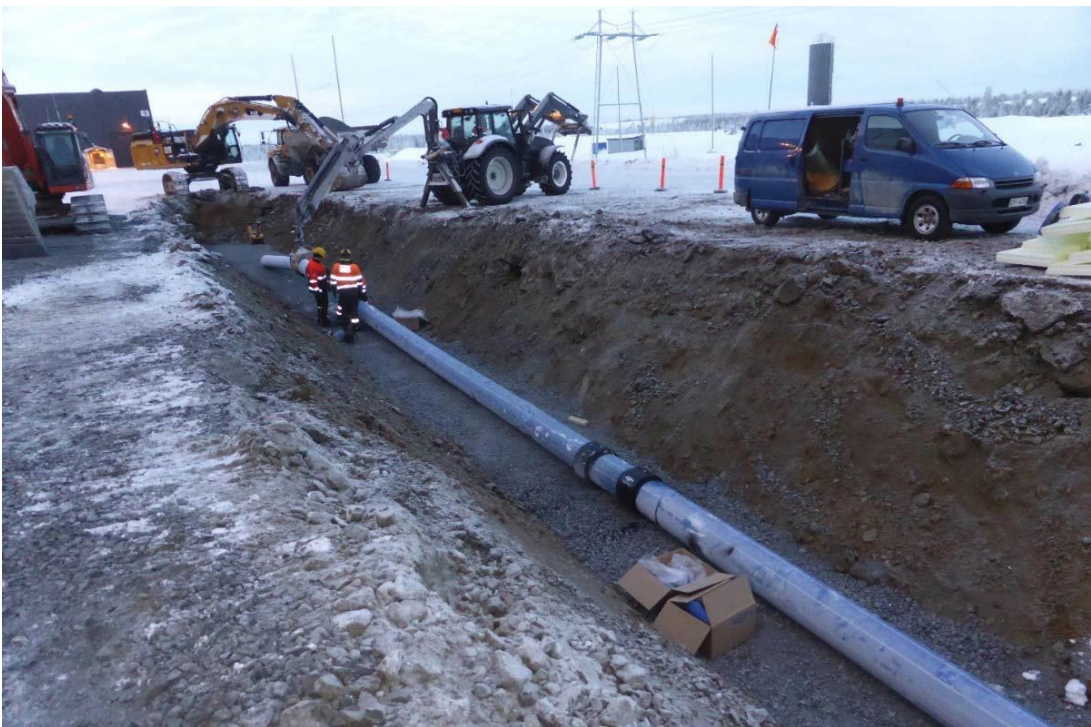
Kuva 25. Putki on asennettu putkiarinan pohjalle. Putkilinjassa käytettiin hyväkuntoisia käytettyjä putkia.
