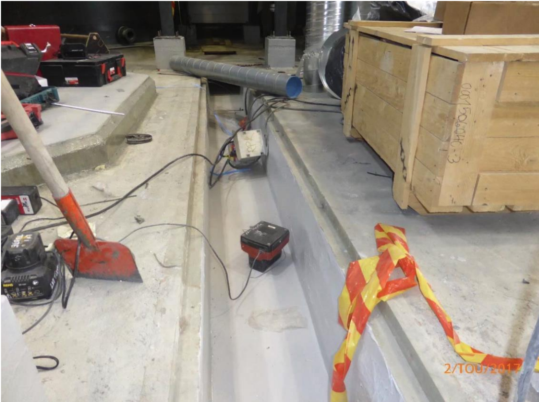
Kuva 24. Pinnoitettu lattiakouru ja säiliöperustus. Lattiapinnat on pinnoitettu viimeisenä työvaiheena toukokuun aikana.
