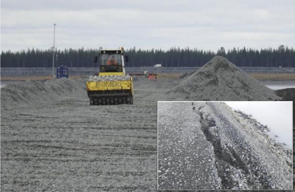
Kuva 10. Sorkkajyrä tiivistämässä louhepengertä ja pienessä kuvassa havaittuja routavaurioita.
