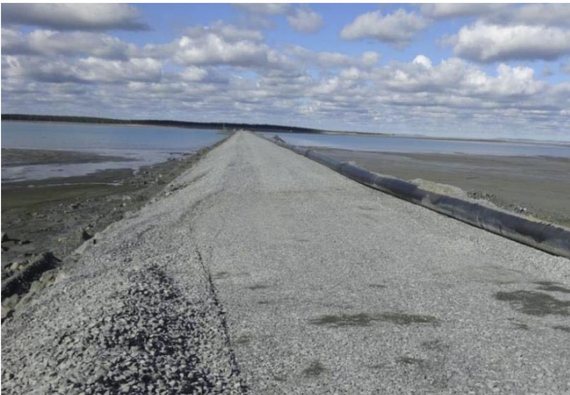
Kuva 11. Valmis tie palautuspumppaamolle. Tiessä ei havaittu muodonmuutoksia korjaustoimenpiteiden jälkeen.
