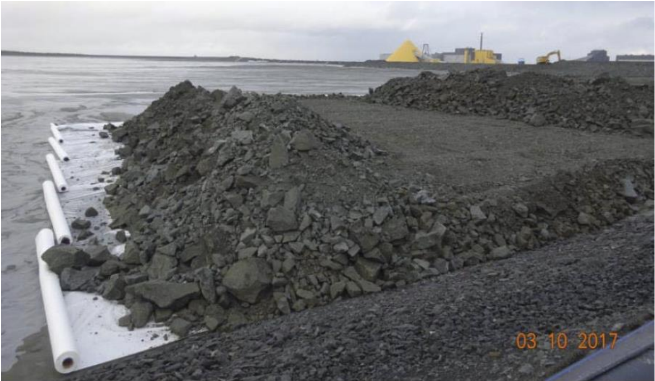
Kuva 9. Suodatinkankaat ensimmäisen louhekerroksen alla paalulla 2300.
