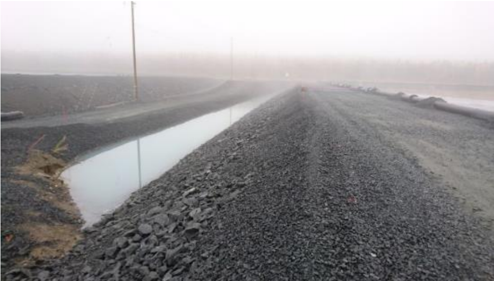
Kuva 15. Padon läpi suotautunutta vettä ojassa.
