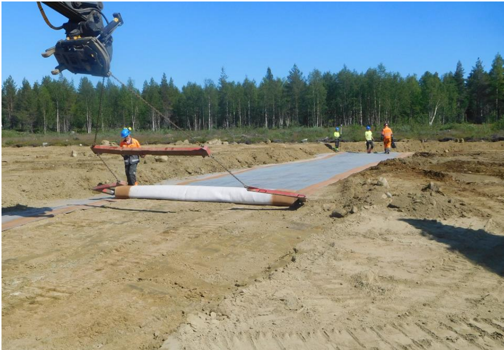
Kuva 9-3. Bentoniittimattojen asennuksessa käytettiin asennuspalkkia. Mattojen asennusalusta oli pääosin tasaista ja kantavaa. Painotuskerros tehtiin pohjan tasauksen yhteydessä poistetusta moreenista sekä moreenin ottoalueelta tuodusta seulotusta moreenista.
