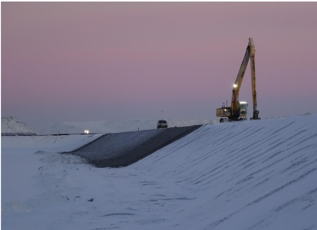
Kuva 9-4. Louheluiska kiilattiin 0-32 mm murskeella ennen suodatinkankaan asennusta. Kiilattu louheluiska soveltui hyvin suodatinkankaan asennusalustaksi.
