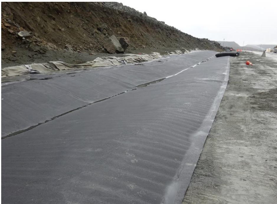
Kuva 9-5. Rompadin ojien kunnostuksen HPDE-kalvot asennettiin kivituhkan päälle. Uusi kalvo liitettiin hitsaamalla vanhaan kalvoon. Kalvon päälle asennettiin geotekstiili ja 300 mm vahva murskekerros.
