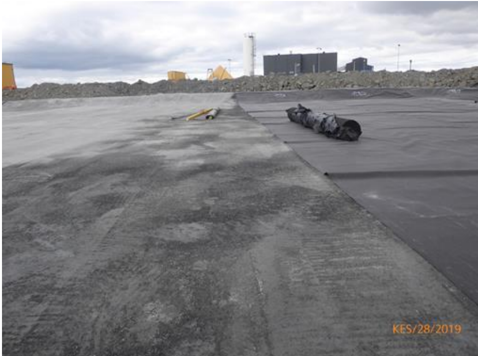
Kuva 9-5. Tiivistetty kivituhkakerros ennen kalvon asennusta. Asennettujen HDPE-kalvojen reunat painotettiin geotekstiilirullilla.
