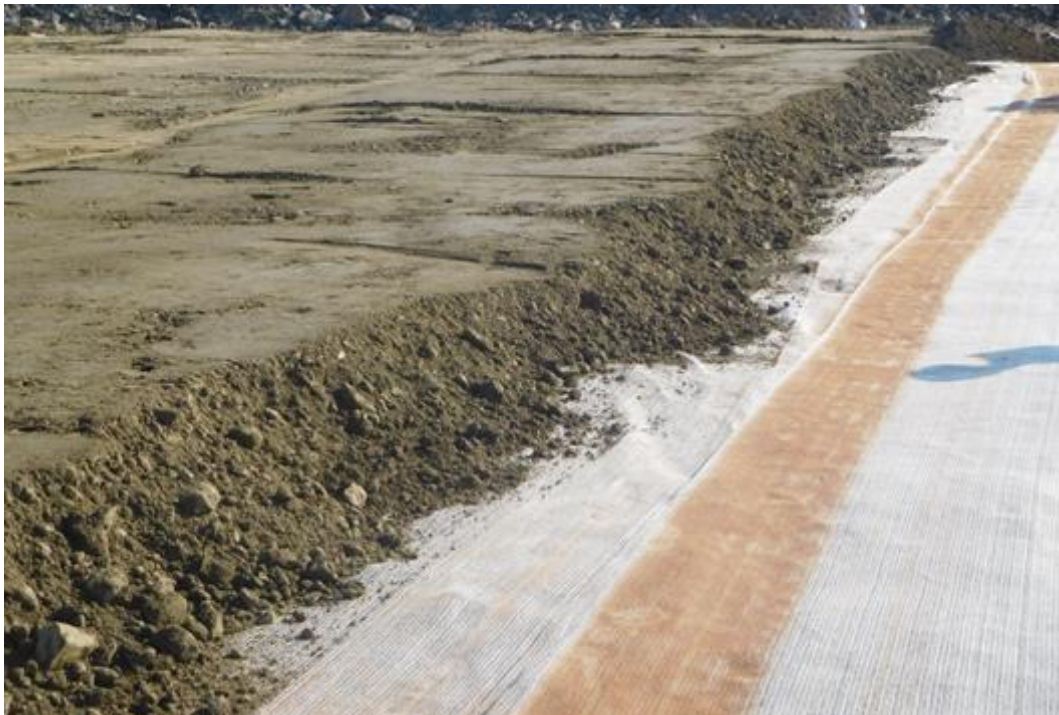
Kuva 9-1. Bentoniittimaton painotuskerros tehtiin moreenista, joka otettiin seuraavan bentoniittimattokaistan pohjan tasauksen yhteydessä. Tarvittaessa moreenia tuotiin muualla sijaitsevalta moreenin ottoalueelta. Bentoniittimaton painotuskerros oli hyvälaatuista moreenia.
