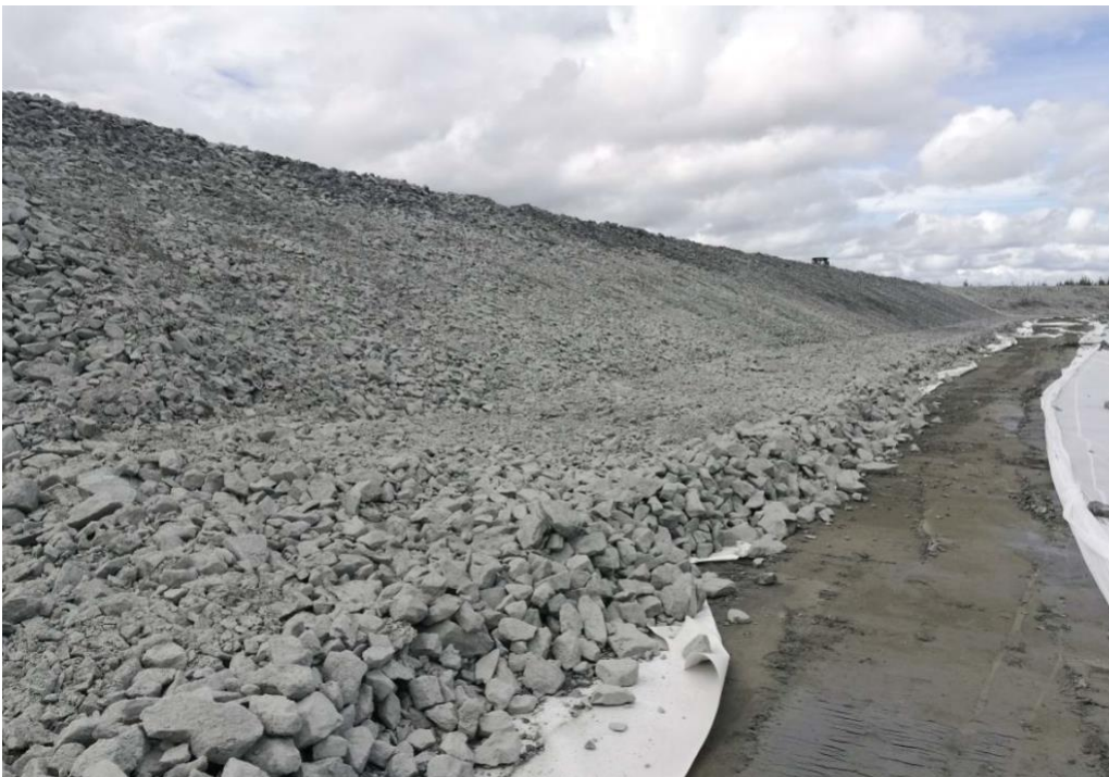
Kuva 9-4. Rikastushiekka-altaan A vaiheen 6 mären puolen luiskan eroosiosuojausta.
