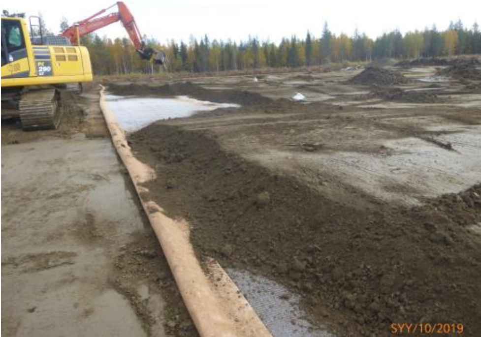
Kuva 9-3. Bentoniittimaton painotusta sivukivialueella 3.
