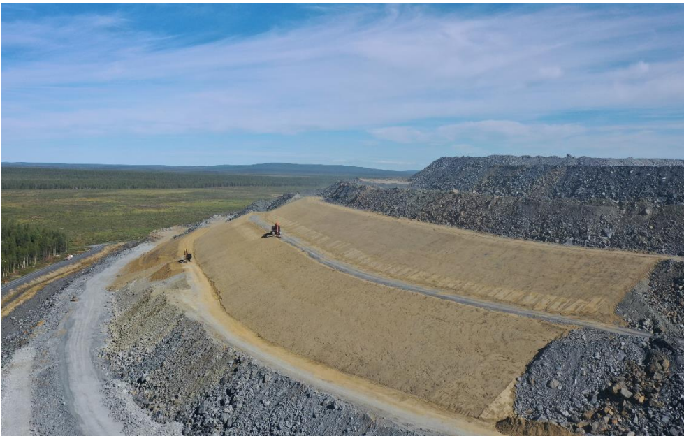
Kuva 9-2. Maisemoinnin tiivismoreenikerrosta sivukivialueella 1b.
