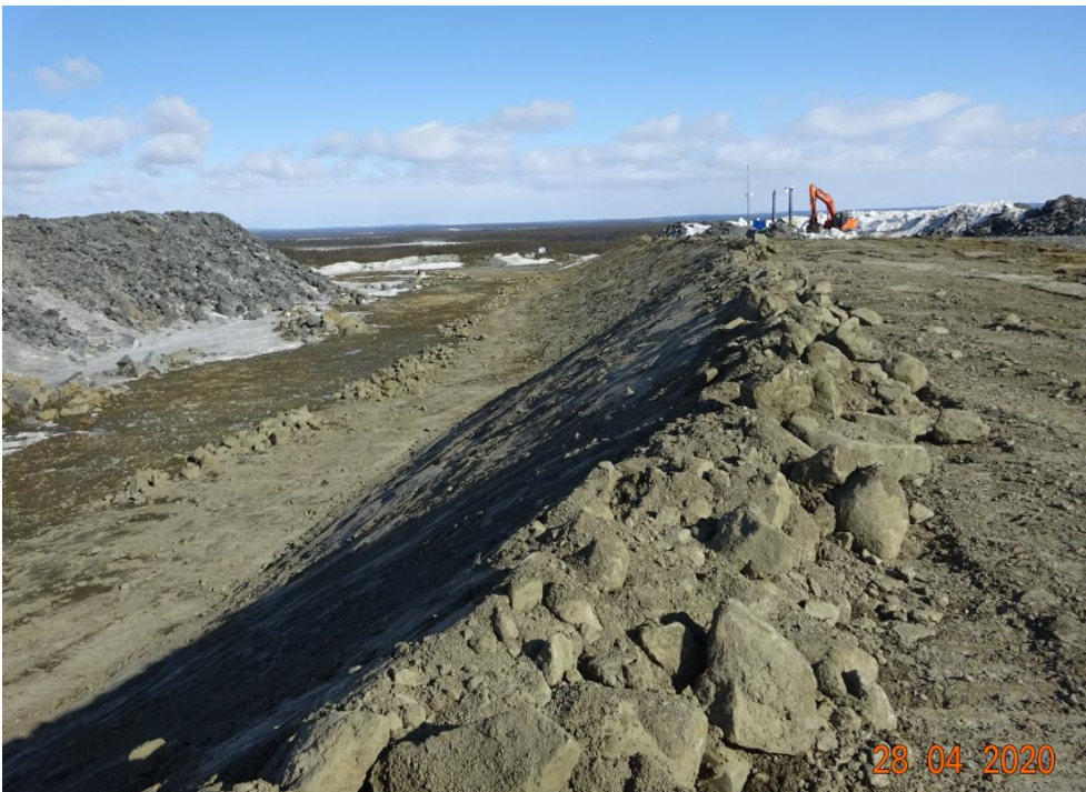
Kuva 9-5. Kapselikiven pohjalle levitettyä moreenirakennetta.
