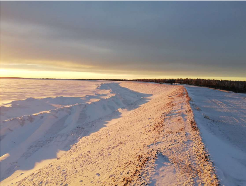
Kuva 9-3. Rikastushiekka-altaan A vaiheen 6 määrän puolen luiskan eroosiosuojausta
