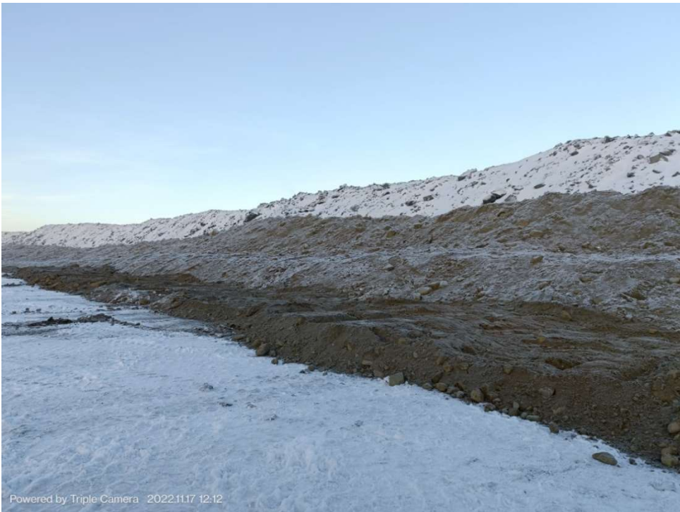
Kuva 9-6. Kapselikiven pohjalle levitettyä moreenirakennetta
