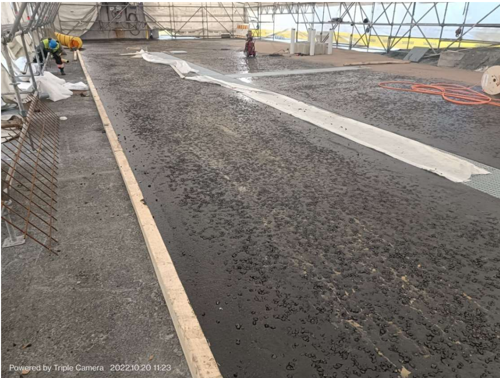
Kuva 9-5. Rikkihapon purkupaikan hapon kestävä asfaltti.
