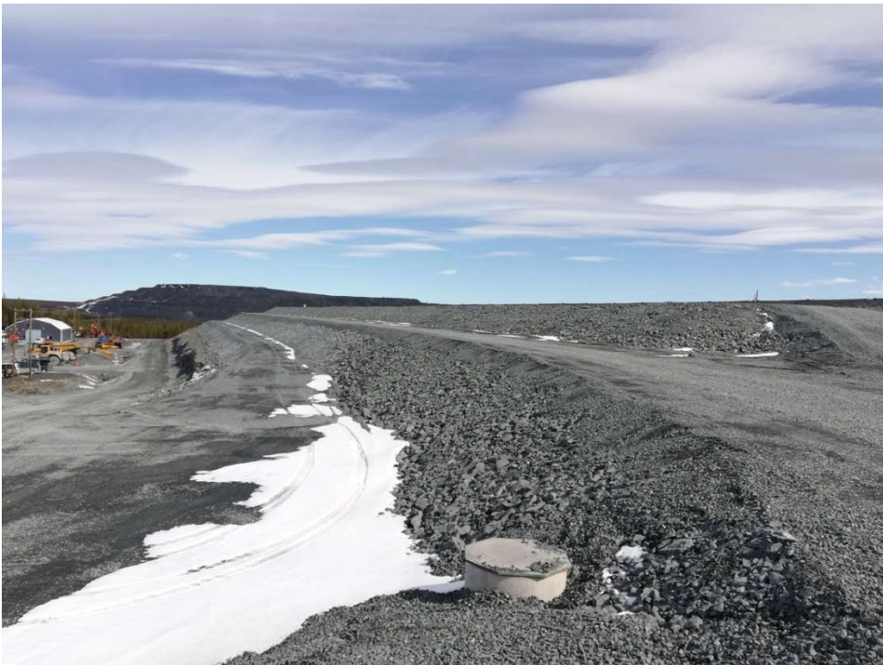
Kuva 9-4. Rikastushiekka-altaan A vaiheen 6 mären puolen luiskan eroosiosuojausta
