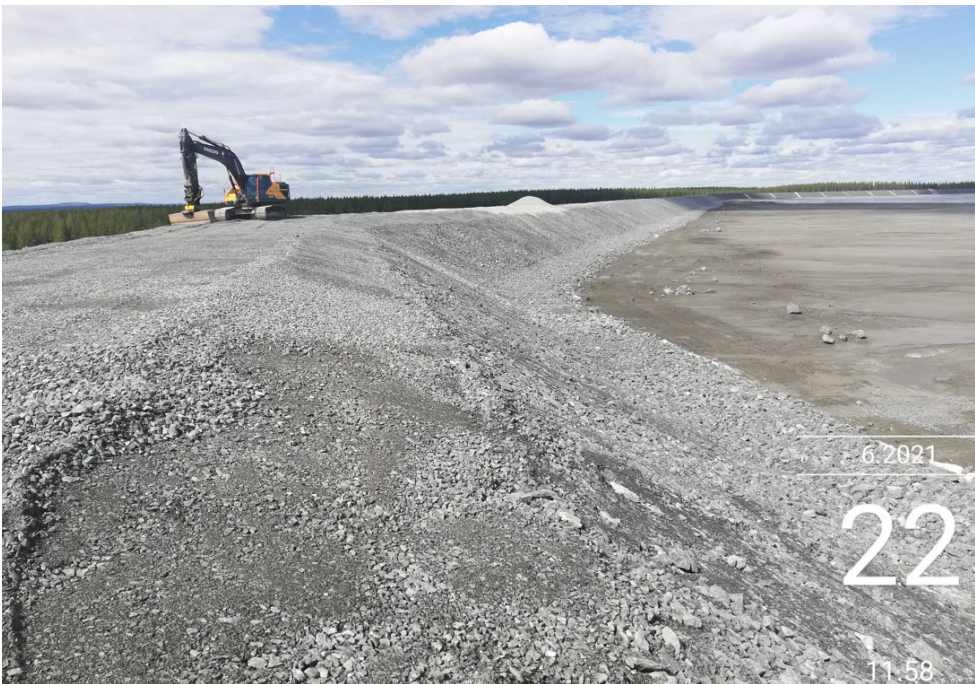
Kuva 9-4. Rikastushiekka-altaan A vaiheen 6 märän puolen luiskan eroosiosuojausta.
