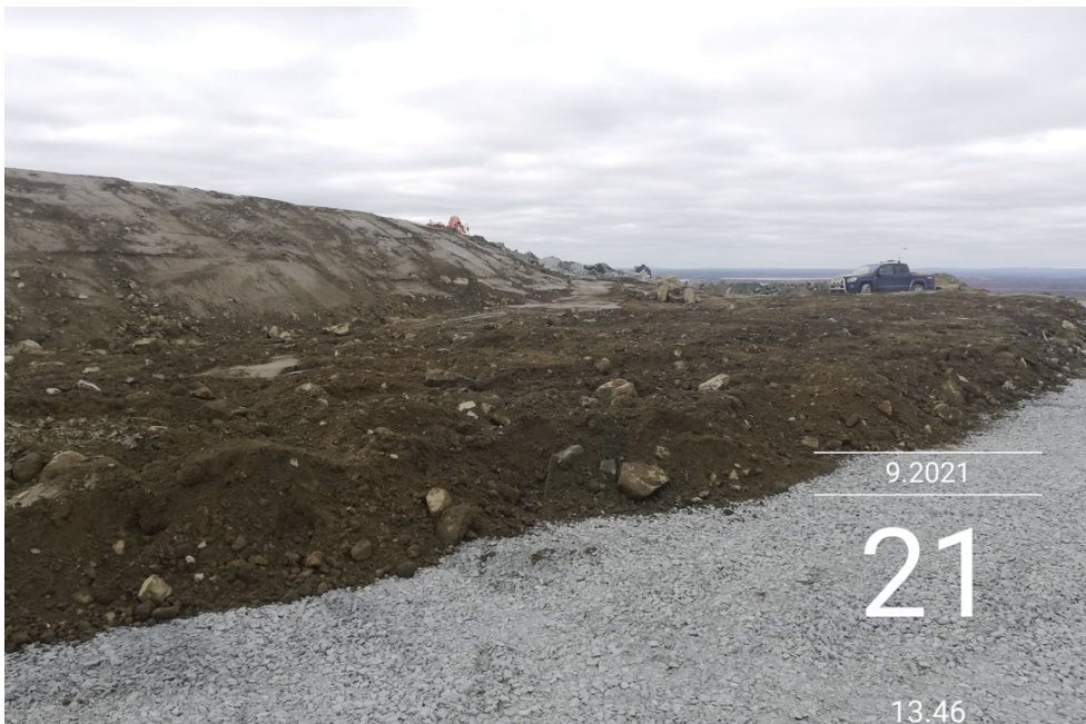
Kuva 9-5. Kapselikiven pohjalle levitettyä moreenirakennetta.
