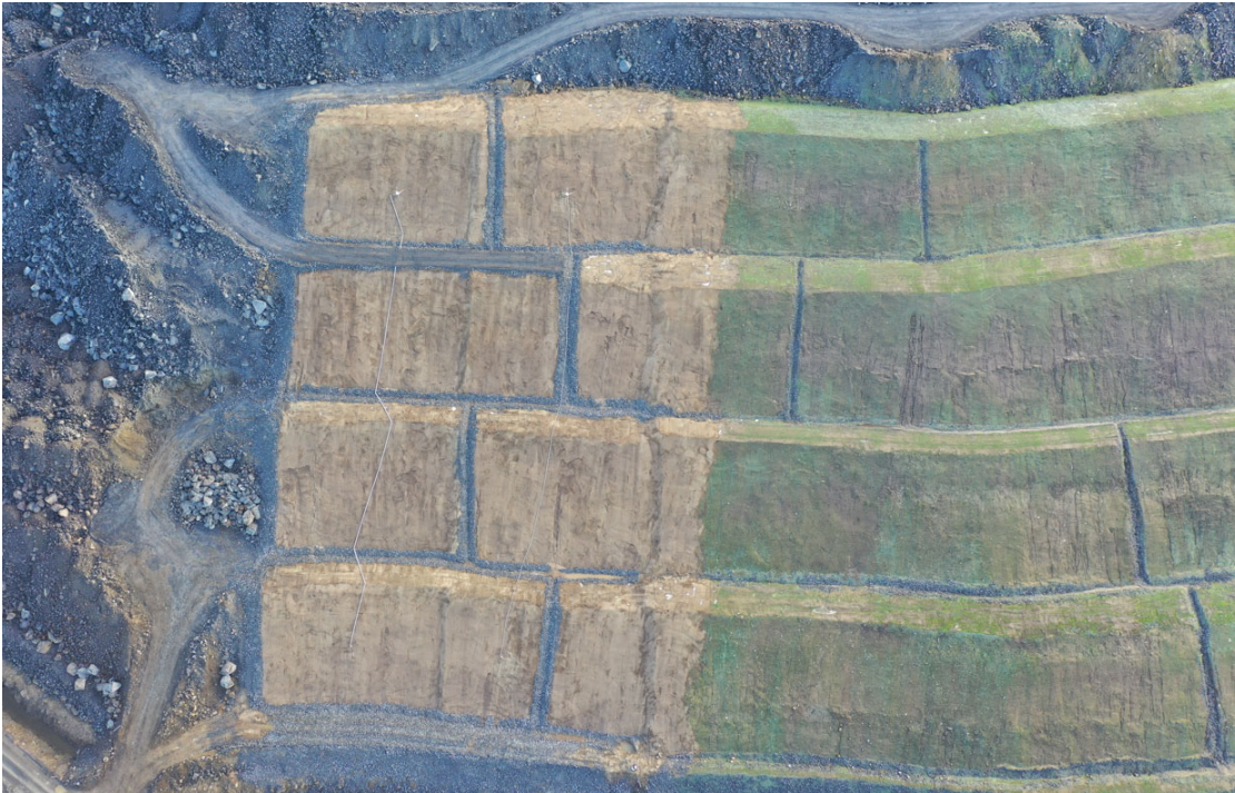
Kuva 9-2. Maisemoinnin bentoniittimattoalue (vasemmalla) liittyy tiivismoreenialueeseen
