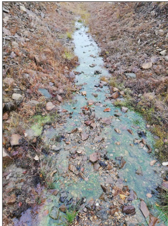
Kuva 23: Kevitsanvaaran rinteestä tulevassa ojassa pohjasta ja luiskista suotautuvaa vettä. / . Water is seeping from the bottom and the embankments/slopes in the ditch downhill of the Kevitsanvaara.
