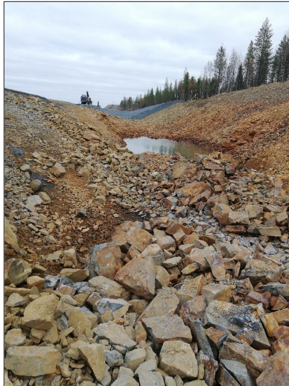
Kuva 22: Altaan B itäpuolen kuivatusojan eteläpään syvennystyö kesken. Kuvaussuunta pohjoiseen. / TSF B drainage ditch under construction. Picture taken towards the north.
