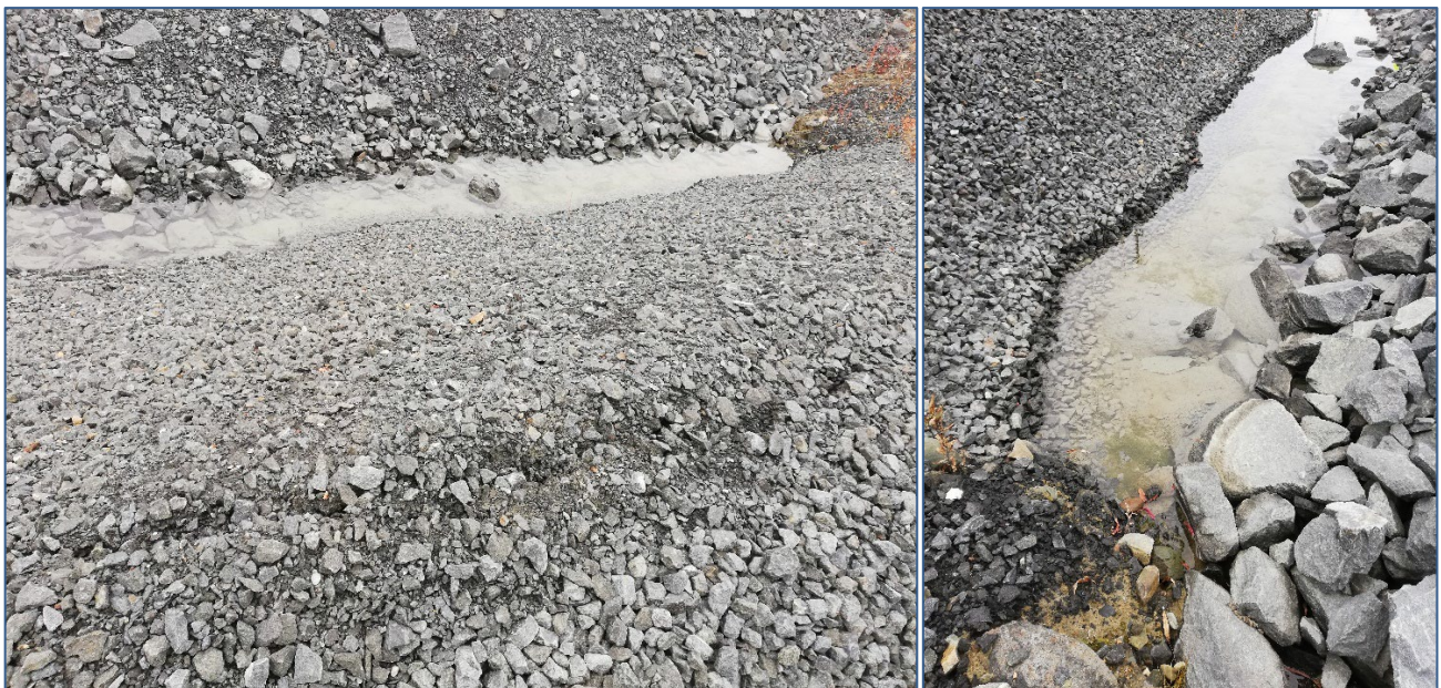
Kuva 21: Vettä alkupadon ja vaiheen 3 korotuspenkereen välissä dekanttitien jatkeella. / Standing water between the starter dam and stage 3 upstream raise on the decant road continuation.
