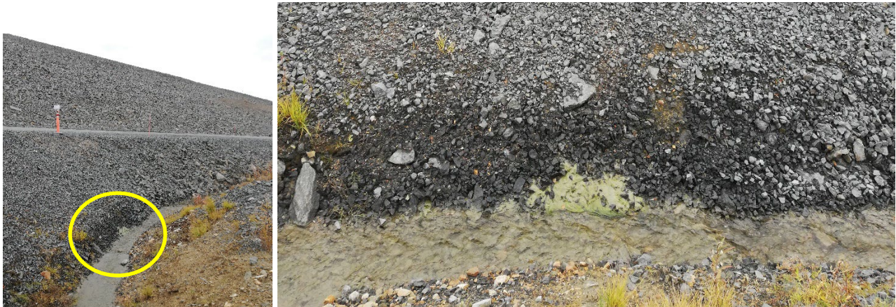
Kuva 20: Esimerkki kohdasta, jossa todettiin vähäistä veden suotautumista altaan A pohjoispuolisen huoltotien luiskasta suoto-ojaan. / Example of minor seepage in the ditch along the northern service road on TSF A.
