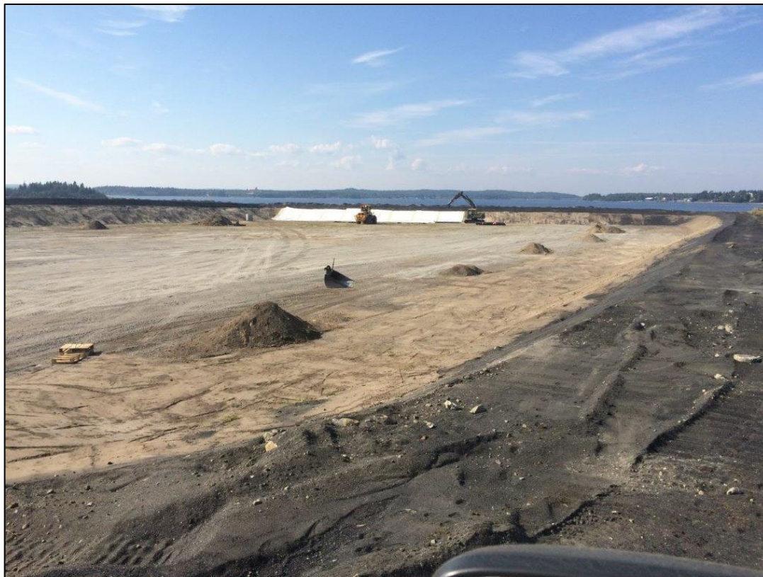
Figur 8. Anläggning av Etapp B, Deponi 16.
