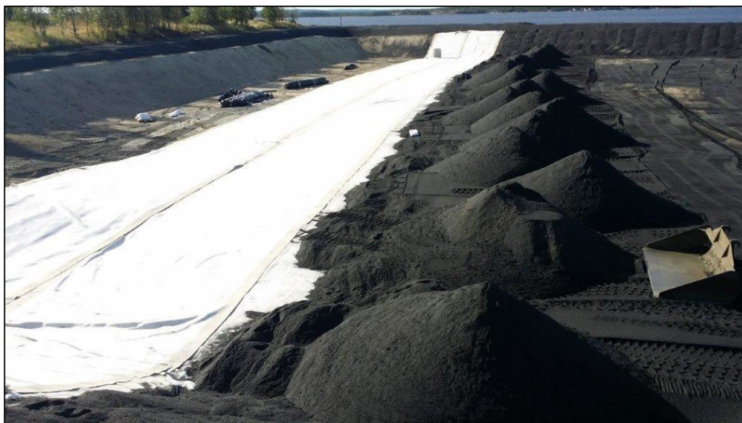
Figur 9. Anläggning av Etapp B, Deponi 16.
