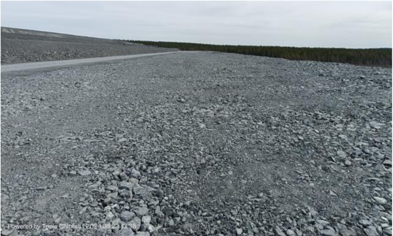
Kuva 3. Rikastushiekka-altaan A eteläinen tukipenger.
