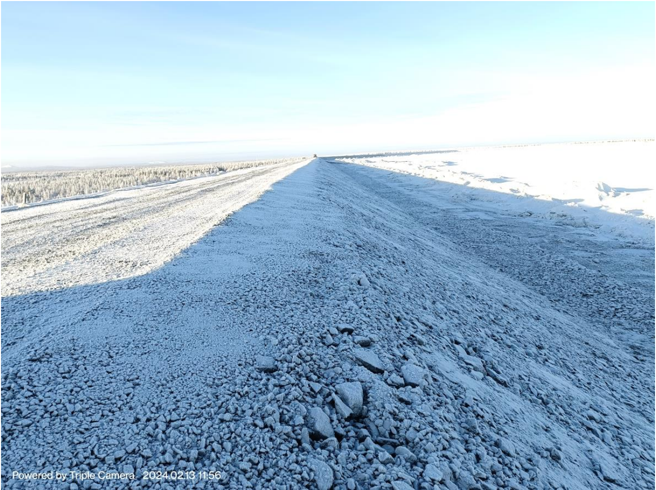
Kuva 1. Rikastushiekka-altaan A vaiheen 8 märän puolen luiskan eroosiosuojausta.
