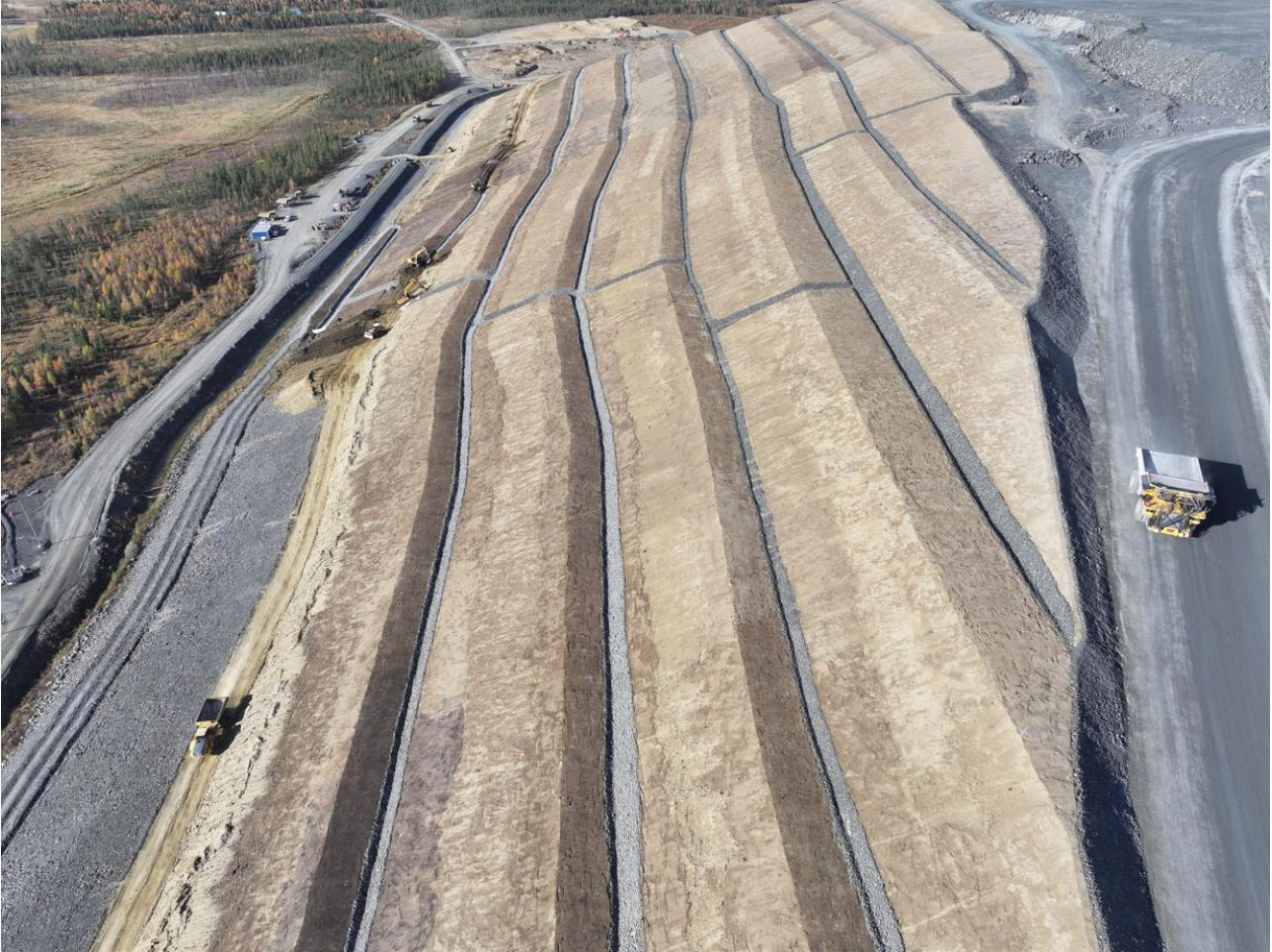
Kuva 6. Sivukivialueen peittorakenne 11 ha.
