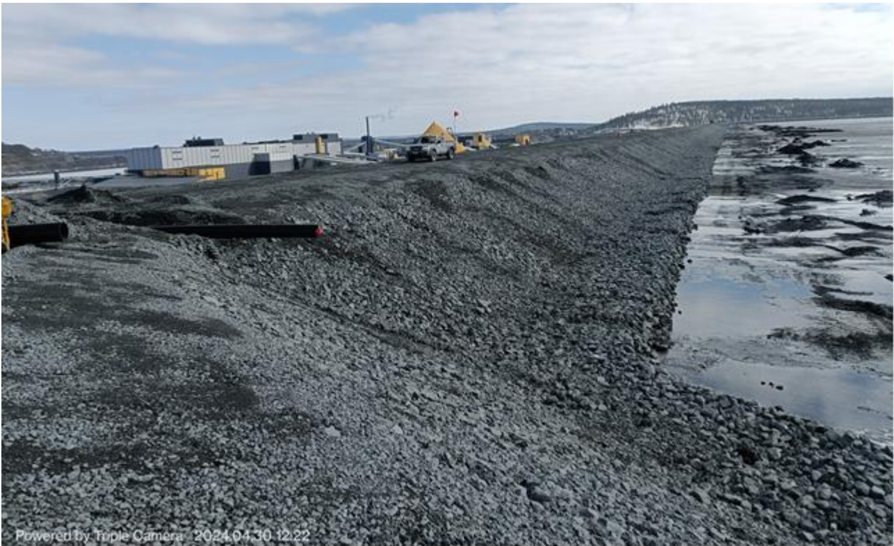
Kuva 2. Rikastushiekka-altaan A vaiheen 8 märän puolen luiskan eroosiosuojausta.
