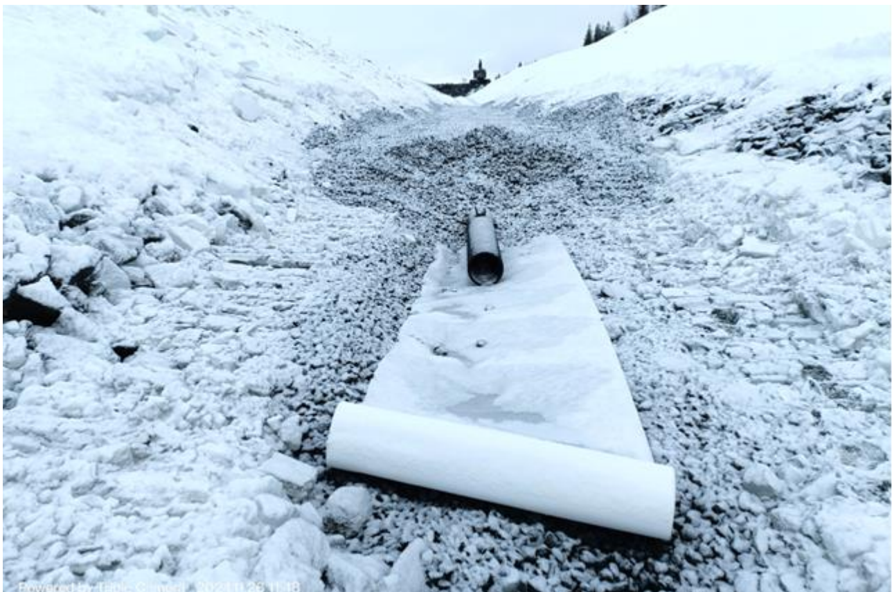
Kuva 4. Sivukivialueen 1a laajennus.
