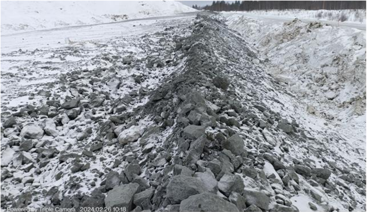
Kuva 5. Sivukivialueen 1a laajennus.
